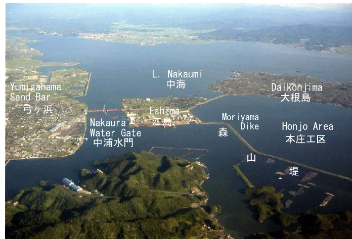
Fig.3 Bird View of the Honjo Area and L. Nakaumi 図3 島根半島側より中海方面を望む
